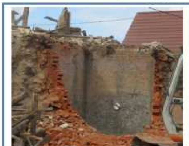
Vue sur le four lors de sa démolition en 2023
